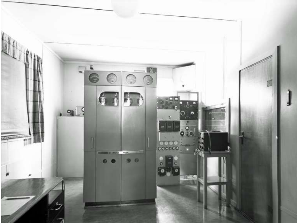
Fra senderhus LKN Notodden Kringkaster 1962 med 1 kW Western Electric senderen fra 1951(1115 kHz). Bilde: Notodden Historielags samling.
